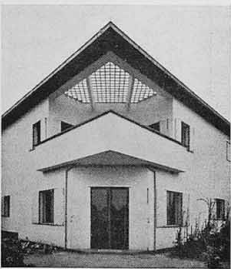
Aus Bruno Taut „Ein Wohnhaus“ Franksche Verlagshandlung W. Keller & Co., Stuttgart
